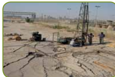
نمایی از دستگاه حفاری مستقر در محل گمانه
