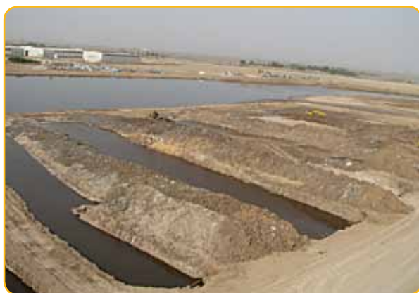
تحکیم بستر برای احداث واحد صنعتی - ماهشهر
