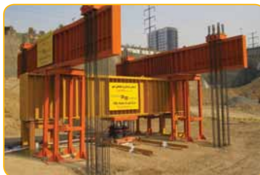
آزمایش بارگذاری استاتیکی شمع (پروژه مخابرات تهران - ۱۷۵۰ تن)
