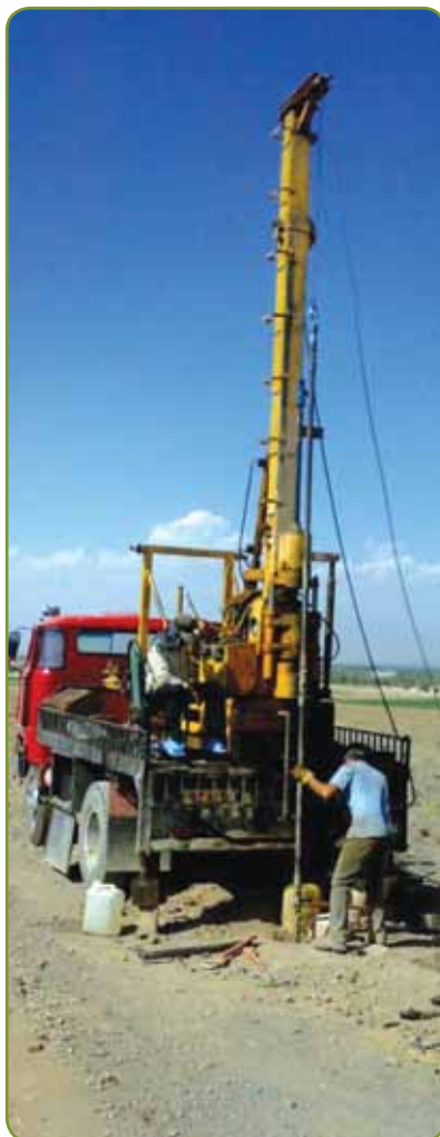
حفر ۱۶ گمانه ماشینی در مرحله مقدماتی و ۶۱ گمانه در مرحله تکمیلی به منظور شناسایی لایه‌های خاک
