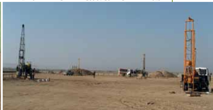
تصویر دستگاه‌های حفاری بر روی گمانه‌های مختلف در سایت CPF
