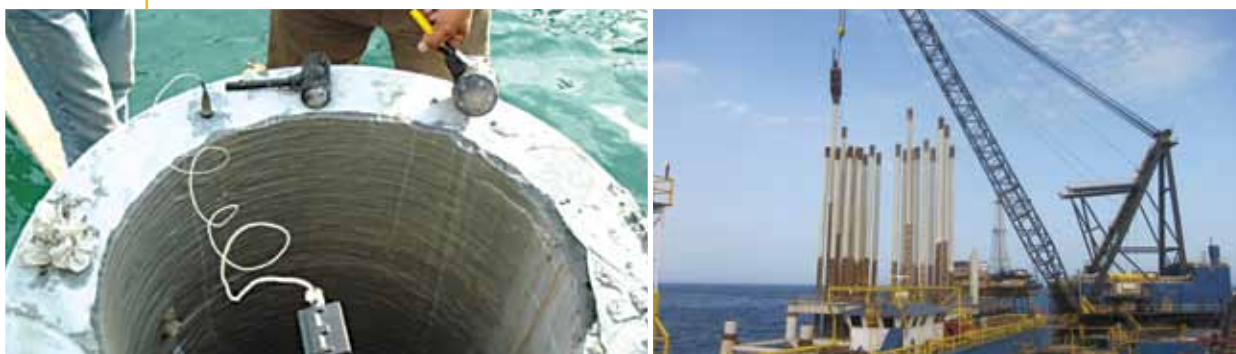
آزمایش کنترل یکپارچگی یا سلامت شمع (PIT)
