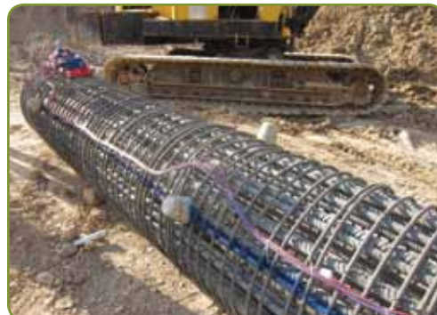
نصب ابزار در شمع درجاریز
